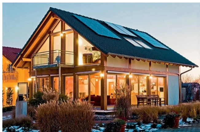
Рис. 8. Энергопассивный дом с элементами фотоэлектрической установки
