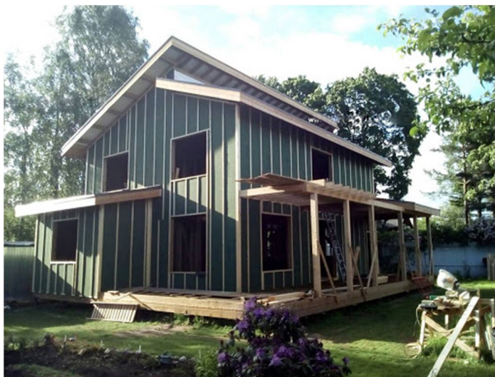
Рис. 3. Применение экологической скандинавской плиты «Изоплат» в каркасном строительстве
