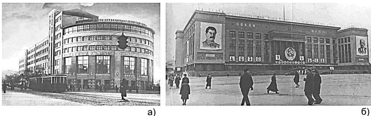
Рис. 1. Постройки архитектора А.И. Попова-Шамана в Воронеже: а) Дом торговых организаций «Утюжок», 1930 г., б) здание Обкома ВКП(б), 1938 год
